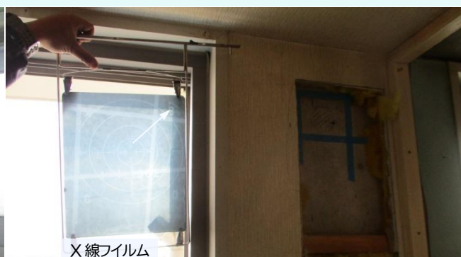
図 10 冷媒管用スリーブ削孔ーX 線フィルムとの照合
