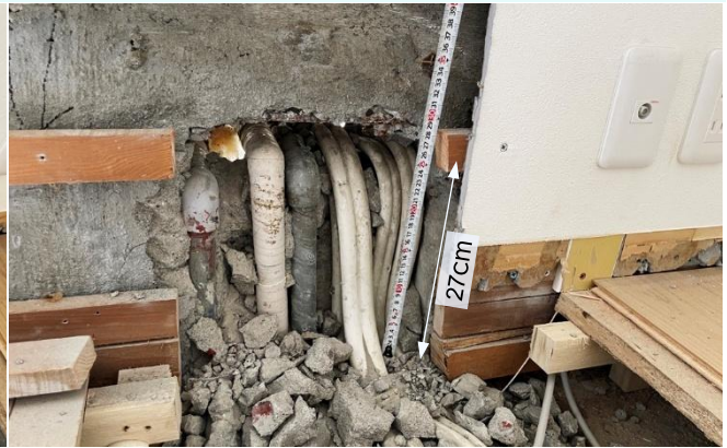
図8 モルタル解体
