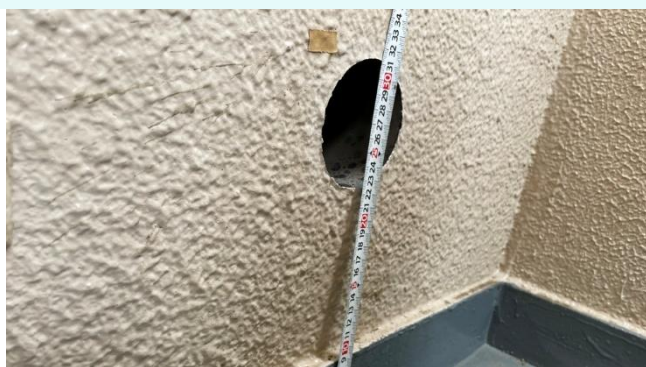
図6 スリーブ削孔
