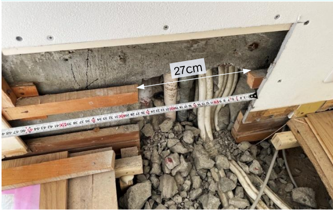
図7 モルタル解体
