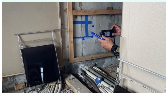
図5 削孔位置確認
