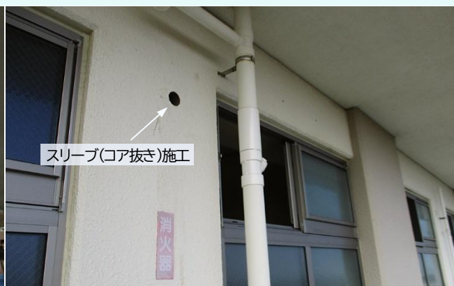
図 8 冷媒管用スリーブ削孔後
