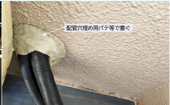
図 12 配管（スリーブ通し）－躯体壁
