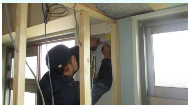
図 9 冷媒管用スリーブ削孔ー墨出し
