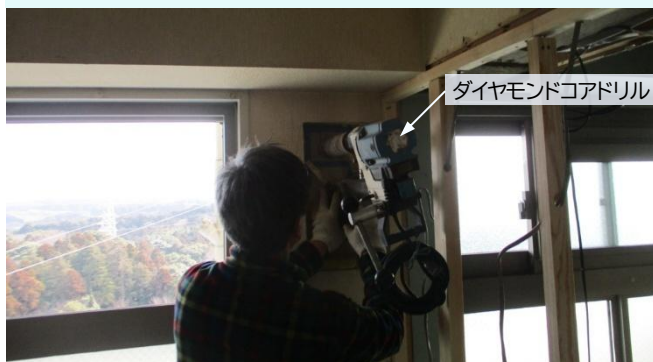
図 11 冷媒管用スリーブ削孔中
