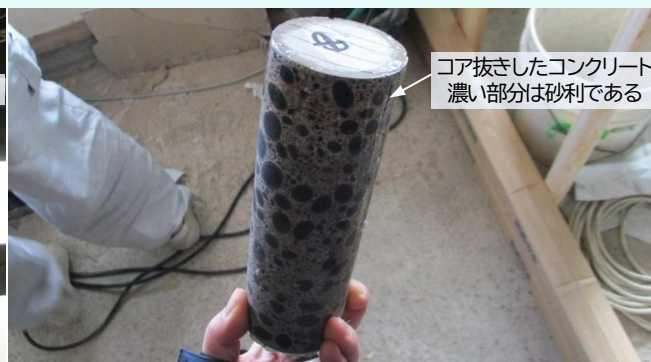
図 12 冷媒管用スリーブ削孔後ーコア抜きしたコンクリート
