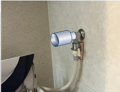
図 9 止水栓への取付イメージ
