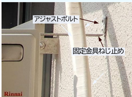
図 3 給湯器固定金具の取付け
