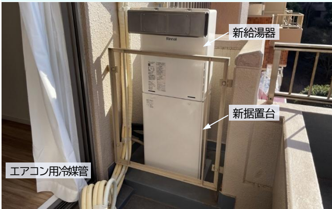
図 11 給湯器設置
