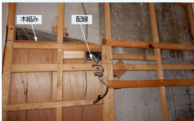
図 6 配線設備（図面化されていない）
