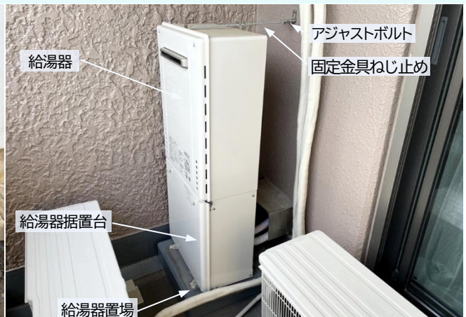
図10 給湯器設置
