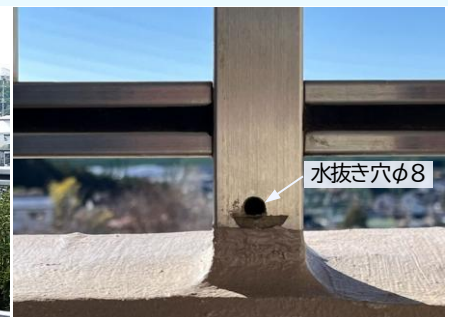
図 5 手摺支柱・水抜き穴(塞がない)
