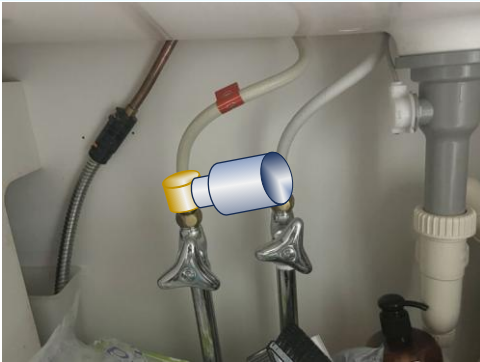
図 8 止水栓への取付イメージ
