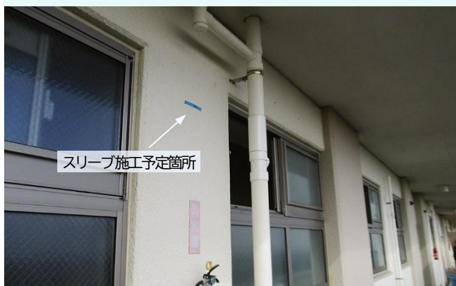
図 7 冷媒管用スリーブ削孔前
