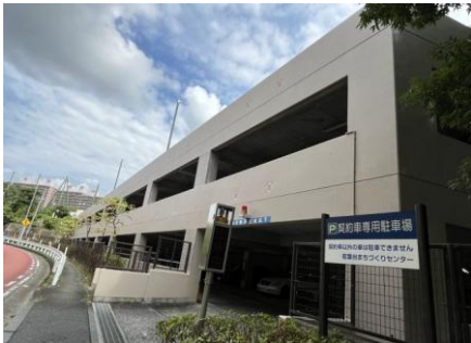
No.1 4 丁目立体駐車場(4-1 号棟脇)
