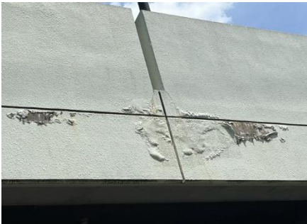
No.3 同駐車場 2F 外壁
