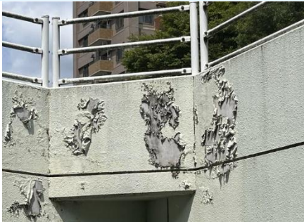
No.5 同駐車場 2F 進入路外壁
