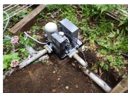
No.3 水中ポンプ・地上部交換後
