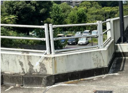
No.6 同駐車場 2F 進入路袖壁
