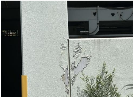
No.4 同駐車場 1F 外壁
